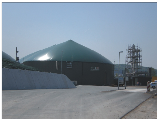
Fot. 1. Zbiorniki fermentacyjne
